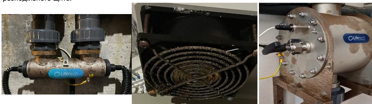
Рисунок 46: Ілюстрація наслідків впливу агресивних хімічних речовин з басейну в машинному відділенні.
