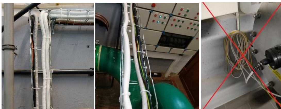
Рисунок 23: Ілюстрація правильного та неправильного прокладання кабелю.
