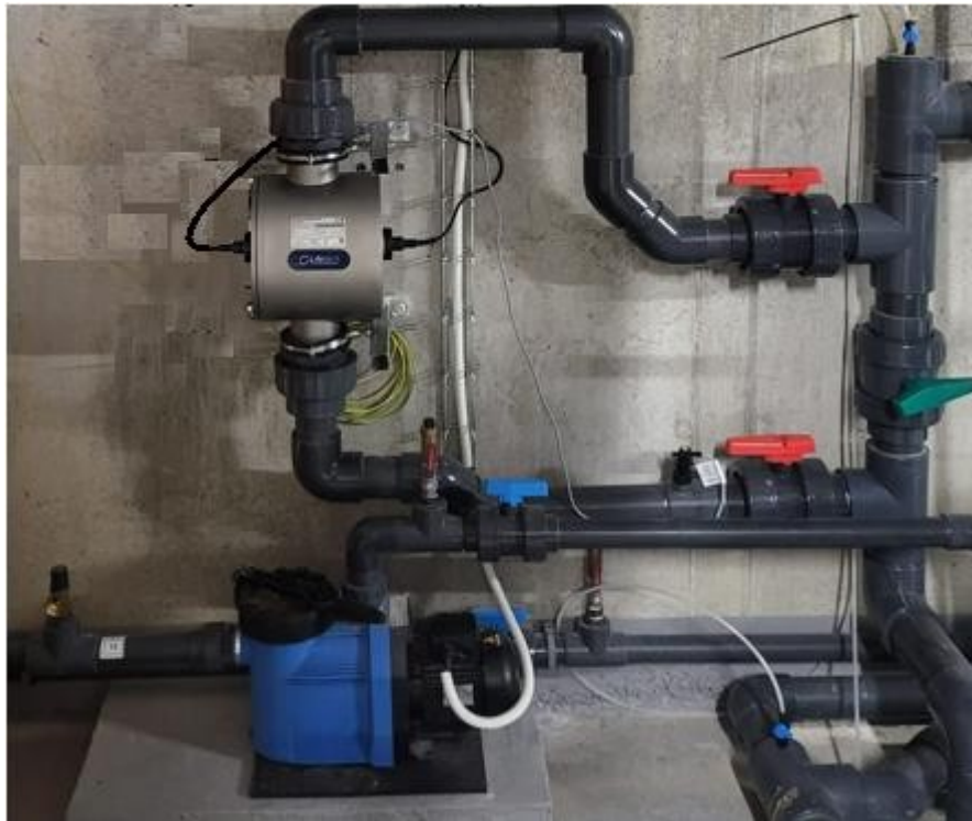
Рисунок 11: Приклад встановлення УФ-системи в обвідний контур.
